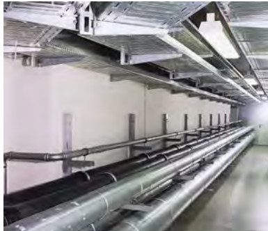
Bevestiging van kabelschachten
