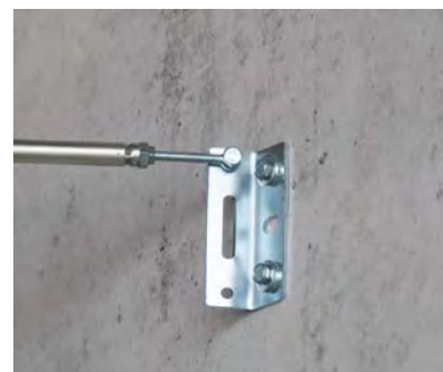
Fixation de supports mureaux et de consoles
