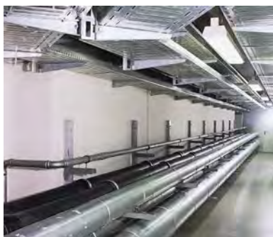
Fixation de conduites de câbles
