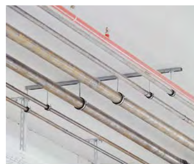
Montage de tubes
